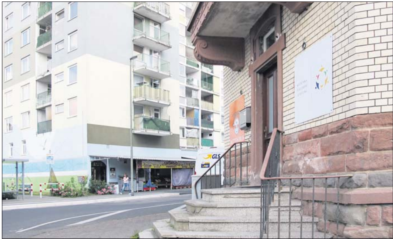
Das „Spessarteck“ an der Alfred-Delp-/Freigerichtstraße trug lange Zeit zum Negativimage des Freigerichtviertels bei. Mit ihrer Kindereinrichtung „Mittendrin“ hat die Kathinka-Platzhoff-Stiftung nun einen Kontrapunkt gesetzt.
