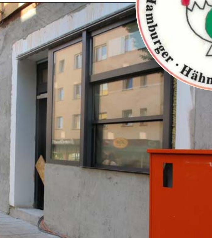
Gab lange Zeit Rätsel auf: Der Umbau des Mertens an der Fahrstraße 12. Bald soll es aber wieder losgehen.
